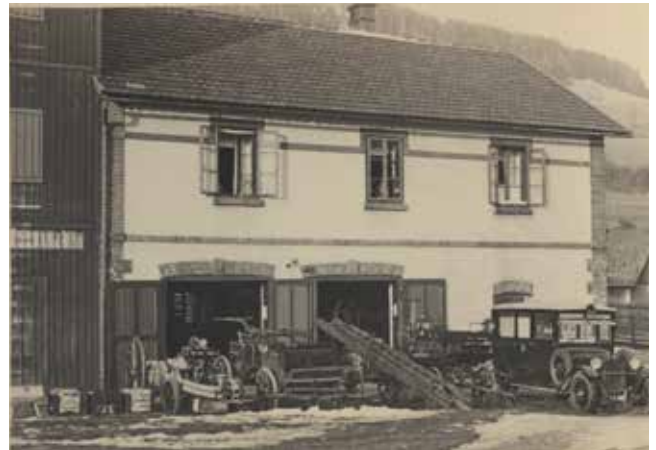
Ausrüstungsstand der Spitaler Wehr 1936
