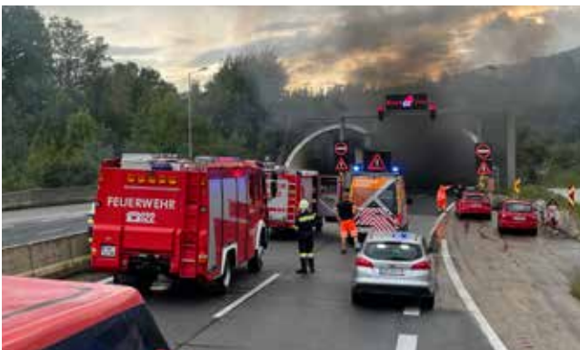
Fahrzeugbrand Tunnel Spital 2022
