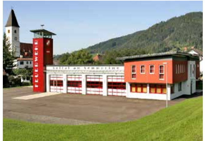
Rüsthausbauarbeiten abgeschlossen April 2008
